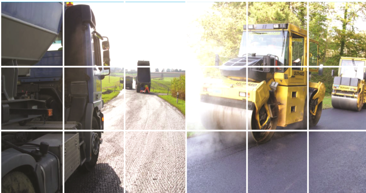
Fertig vorbereitete Belagseinbauflächen
