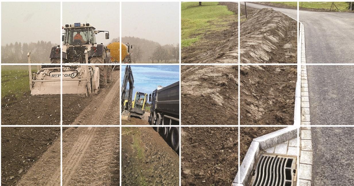
Kalk mit Fräse ins vorgelegte Kies eingefräst / Vorgängige Bankettverstärkung Abschluss mit integriertem Schlammsammler
