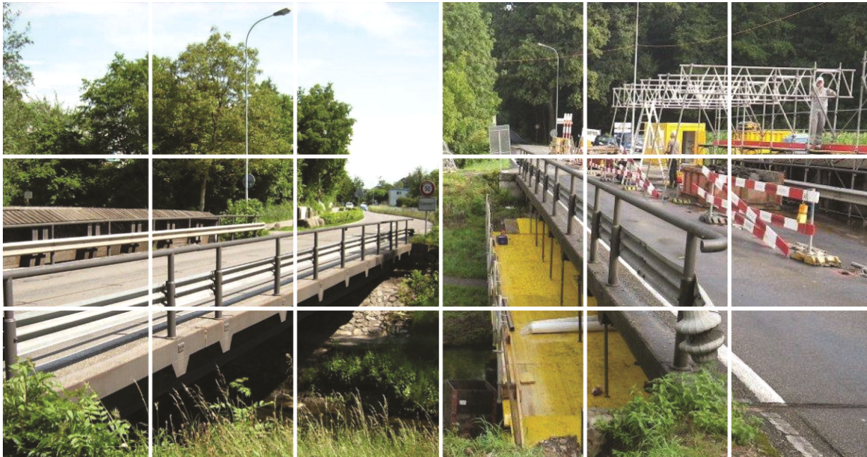
Das 1980 erstellte Provisorium in Stahlbauweise System RUB Gerüstarbeiten
