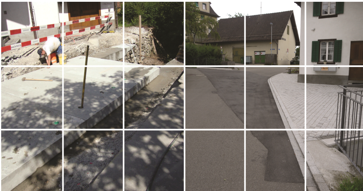
Einbau von Betonfertigteilen über den Hirslenbach
