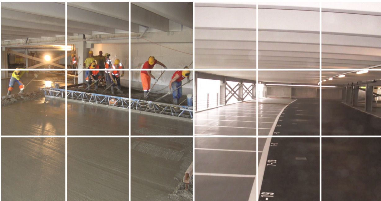
Erstellen von neuem Überbeton
